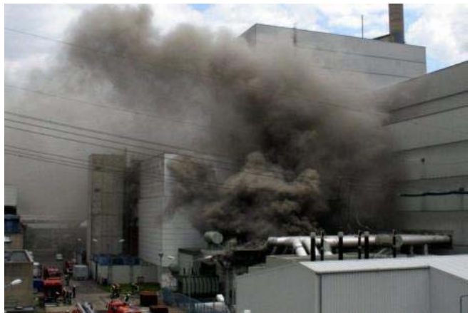
Abschreckendes Beispiel für Verantwortungslosigkeit der großen Energiemultis als Betreiber von Kraftanlagen: Der Schrottreaktor Krümmel (Vattenfall)
